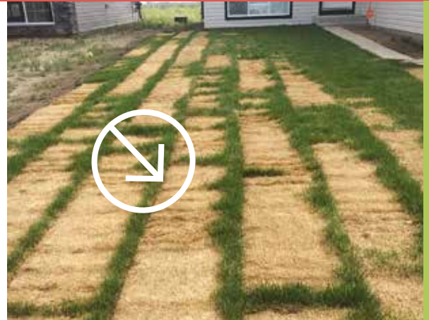
GAZON N'AYANT PAS ÉTÉ INSTALLÉ DÈS SA RÉCEPTION
